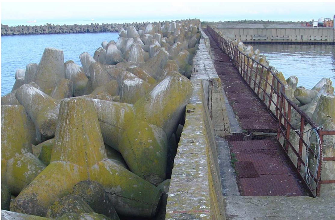
Att.3. Nobīdījušās virsbūves sekcijas (2006 gada foto).
