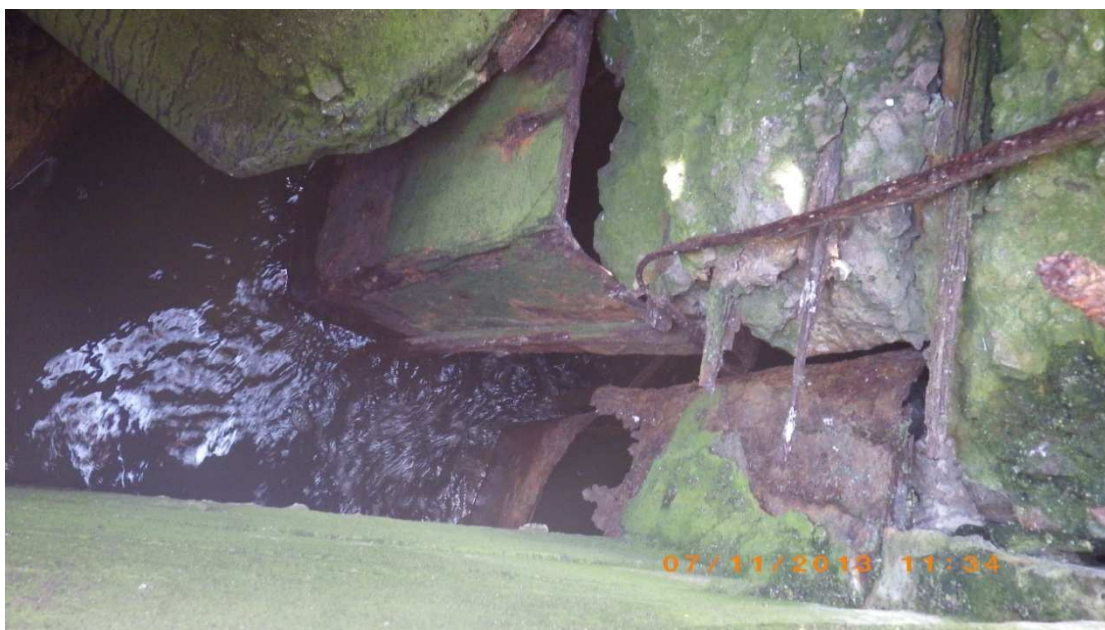
Att.2. Tērauda rievšanas bojājumi mainīgā ūdens līmeņa zonā.
