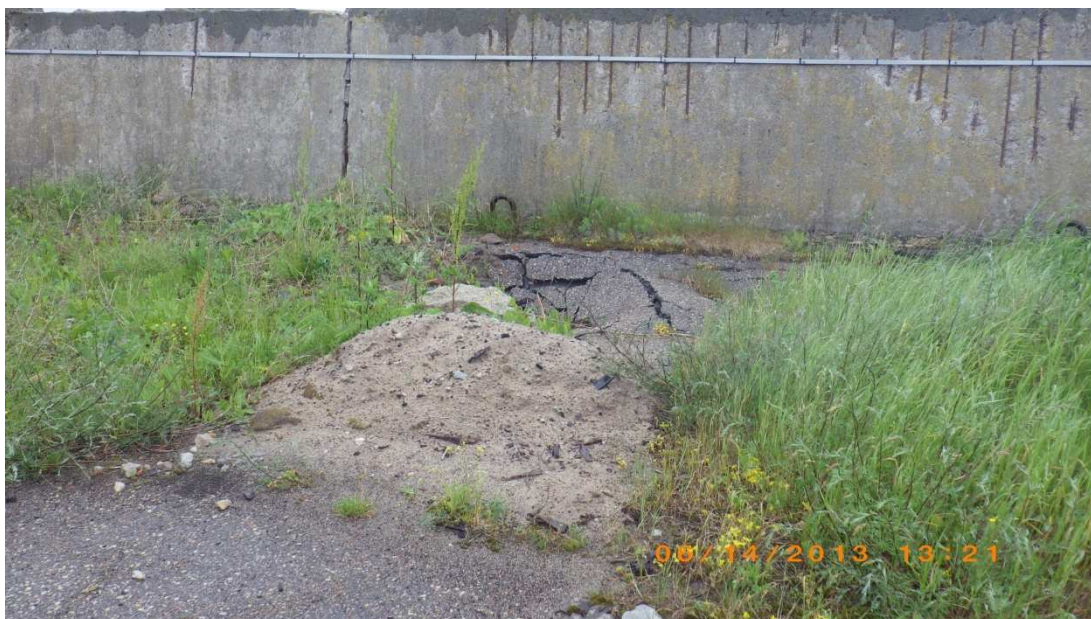
Att.1. Aizbērti grunts iesēdumi, kordodē parapeta sienas stiegrojums.
