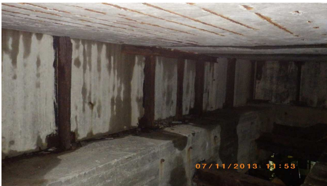
Att.5. Korodē virsbūves seguma plātņu stiebrojums, notiek ūdens caursūkšanās.
